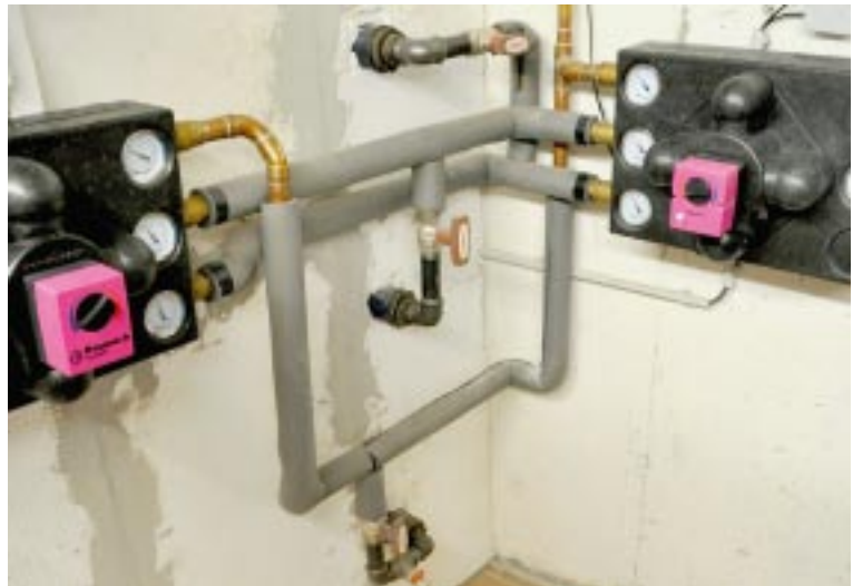
Be- und Entladung des 5 000-Liter-Puffers über die beiden Rendemix-Mehrwegemischer. Details siehe Kasten „Schaltschema“
